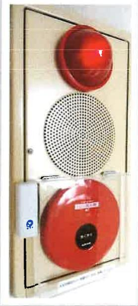
◎「セーフティ・キーパー」は、自動火災報知設備の発信機の上部に取り付けた透明アクリル板カバーと、同カバー側面に取り付けた警報装置により作られています。
